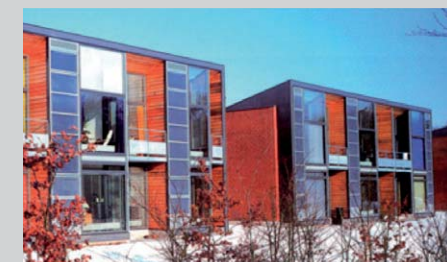
Inserimento di serre e pareti di accumulo
